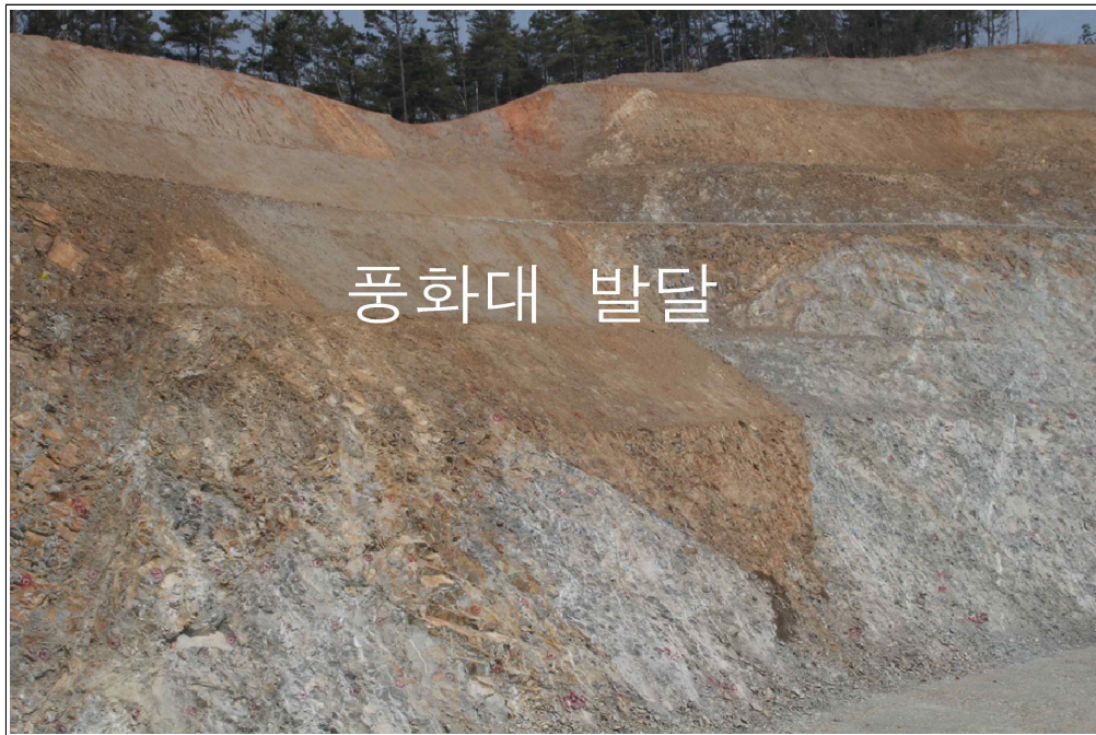
【그림 29】 B 영역 상세사진 (풍화대 발달)
