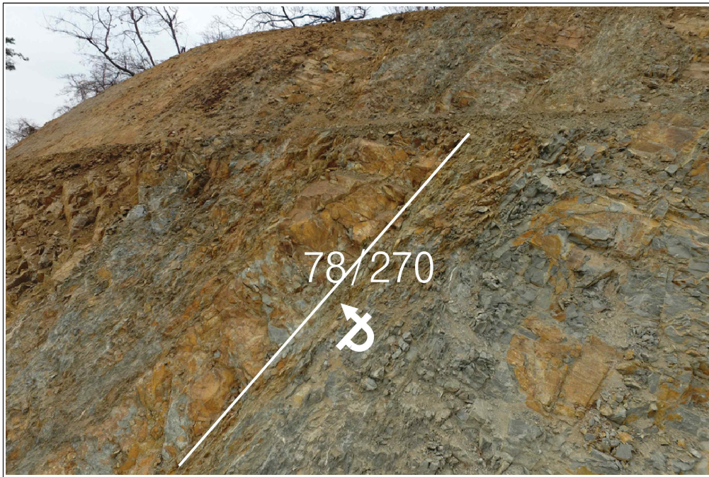
【그림 18】 A 영역에 발달한 불연속면
