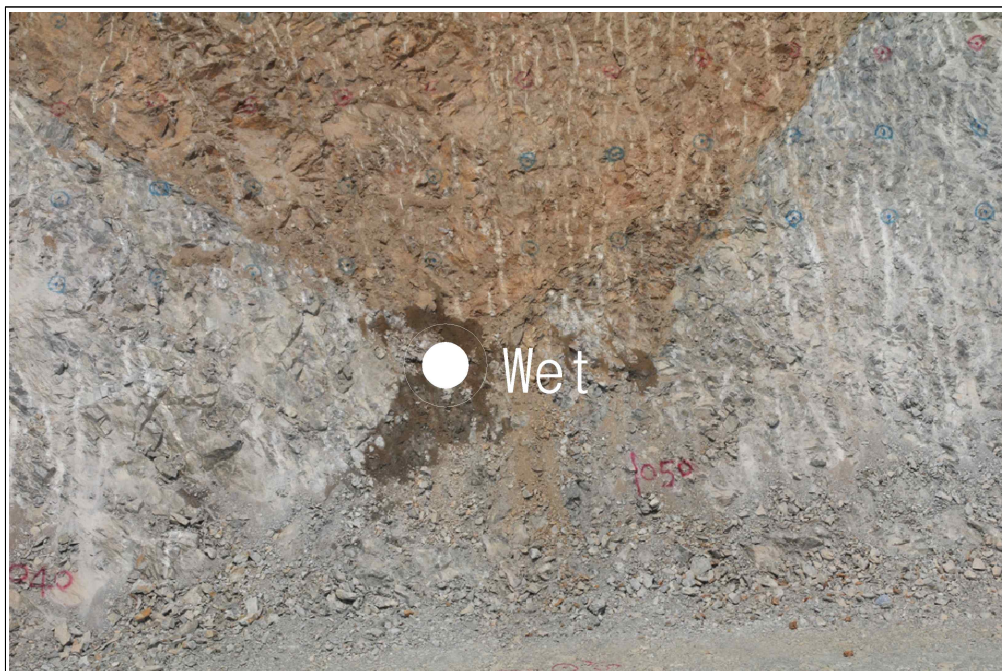
【그림 30】 B 영역 상세사진 (지하수 유출)
