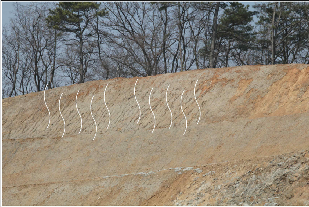
【그림 31】 B 영역 상세사진 (토사유실 및 우류침식)
