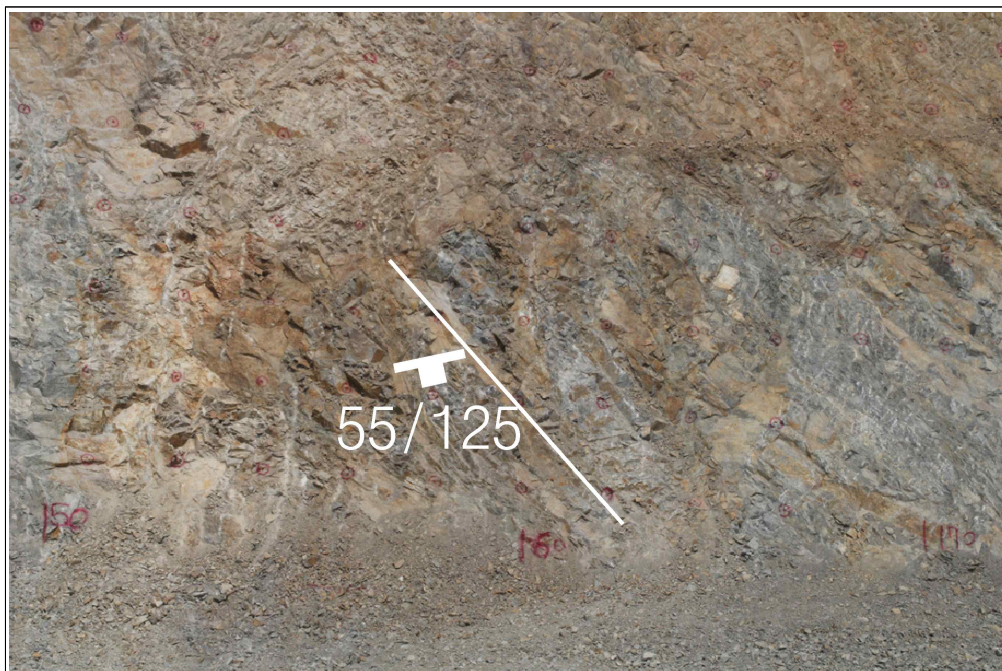
【그림 44】 D 영역에 발달한 불연속면
