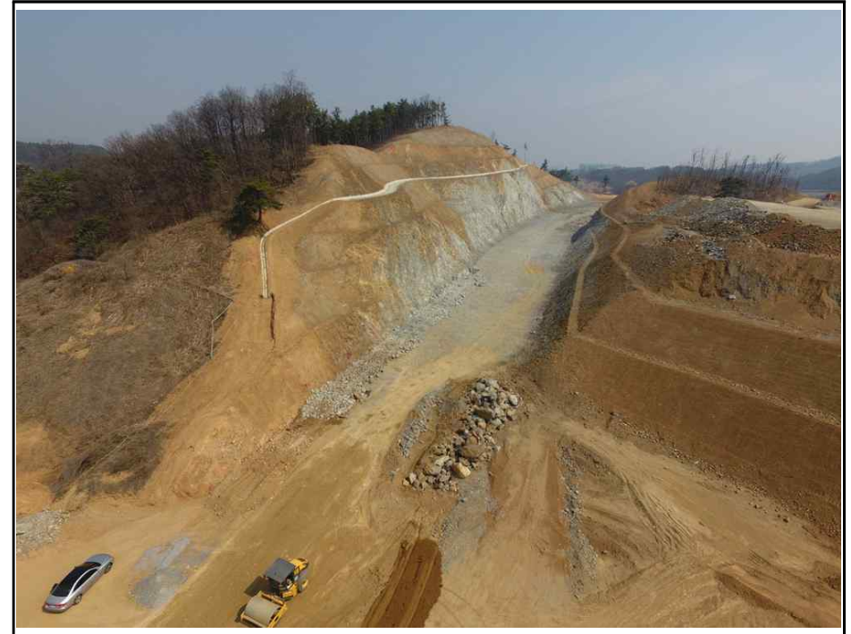
【그림 4】 깎기비탈면 종점부 측면 사진
