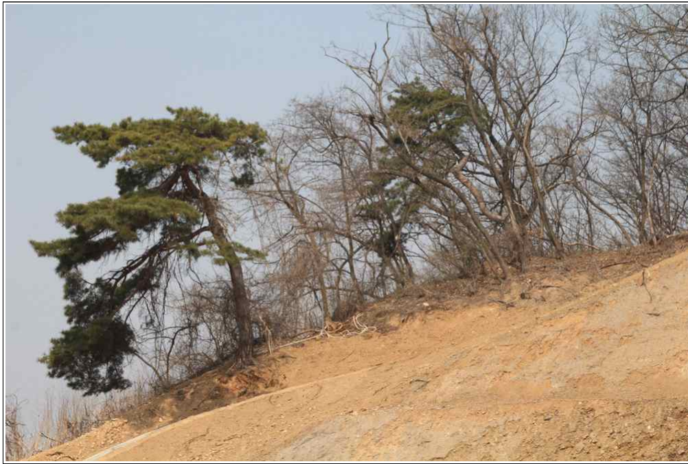
【그림 5】 상부자연비탈면 (수목의 기울어짐 및 포행)
