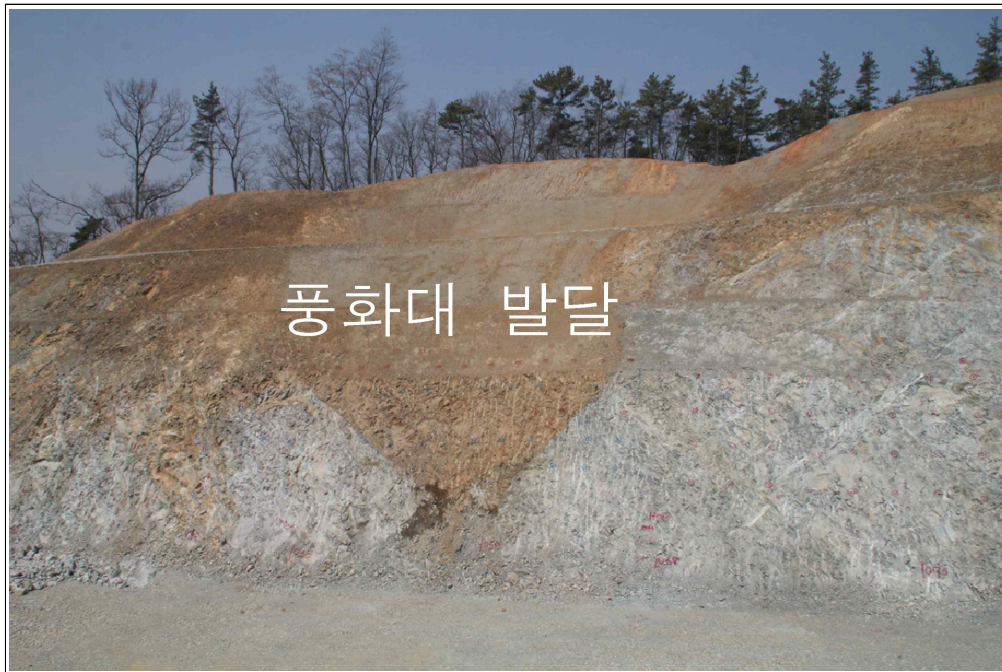
【그림 27】 B 영역 상세사진 (풍화대 발달)
