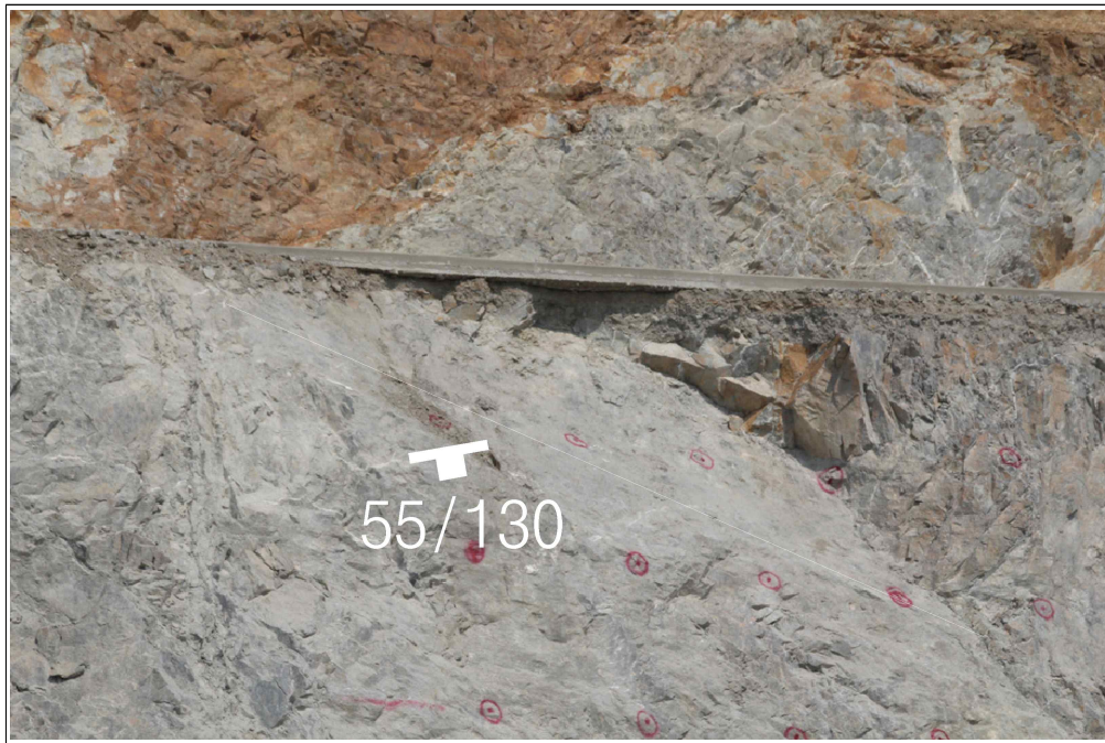
【그림 36】 C 영역에 발달한 불연속면
